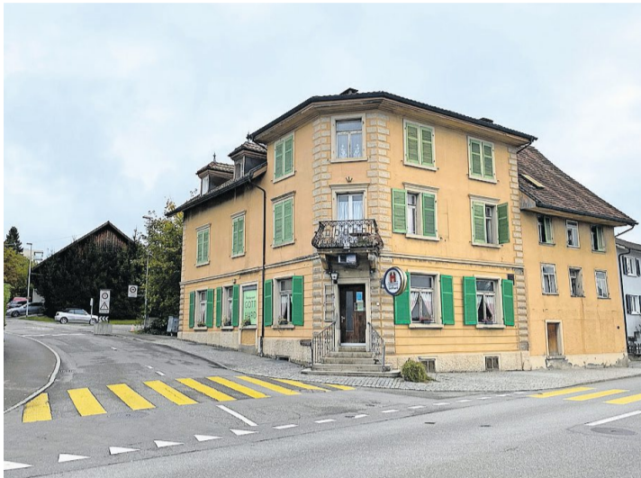
Das Restaurant Gotthard in Wohlen wird in den nächsten Jahren einer Überbauung weichen. Bilder: Marc Ribolla
